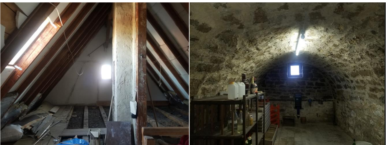
Abb. 4: Gewölbekeller und Dachboden des Wohnhauses
