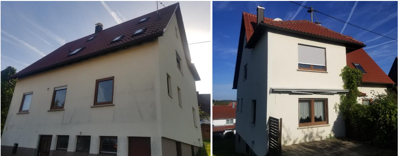
Abb. 5: Außenfassaden des Wohngebäudes
