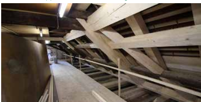
Sanierter Dachstuhl
