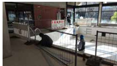
Demontagen am und im leeren Becken
